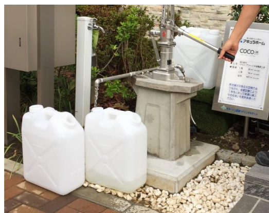
井戸水をくみ上げて供給する様子
